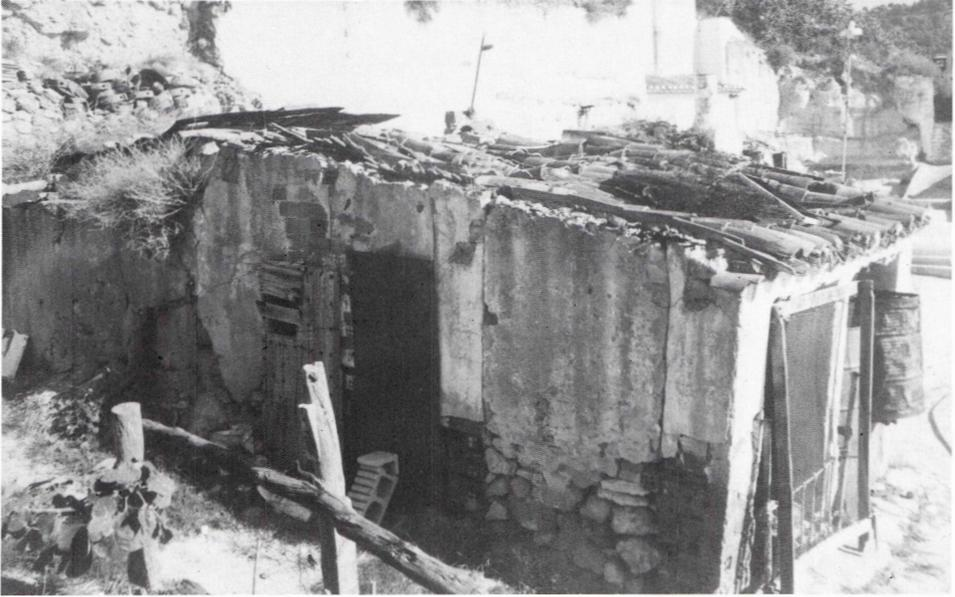
Fot. n.º 7: Exterior del horno árabe de los hermanos Tortosa. En la parte delantera, el leñero; en la posterior, el horno cubierto con chapas metálicas. Se puede apreciar perfectamente el estado semi-ruinoso en el que se encuentra.
