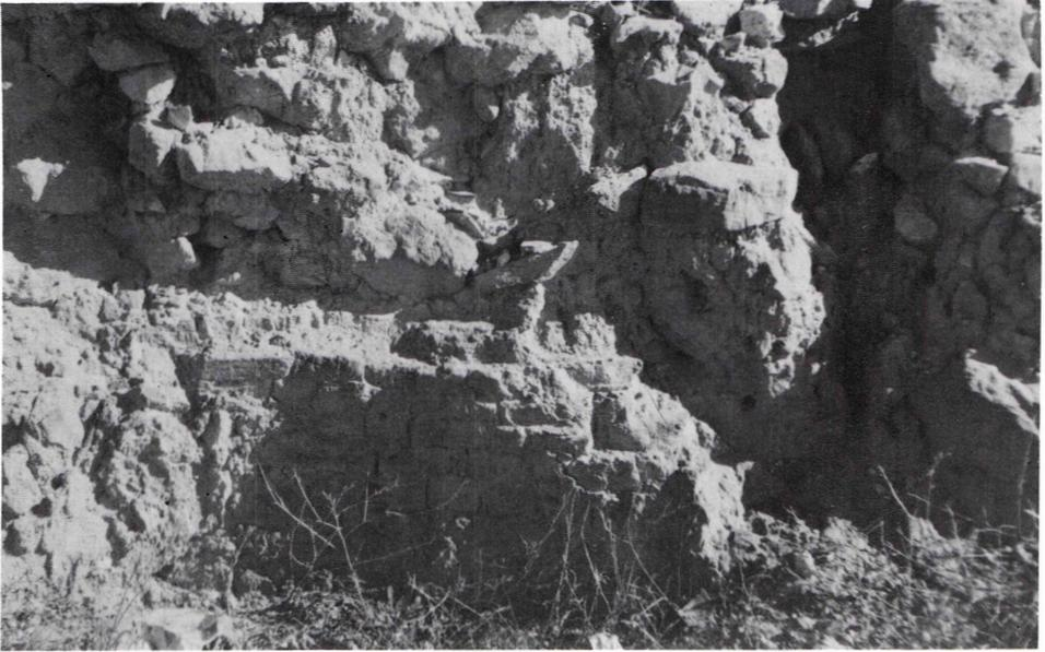
Fot. n.º 9: Aspecto actual del interior del horno árabe de la tejera. Se puede apreciar el doble muro de la construcción. El externo, grueso, de mampostería tosca; el interior, casi totalmente desprendido, de ladrillo refractario.
