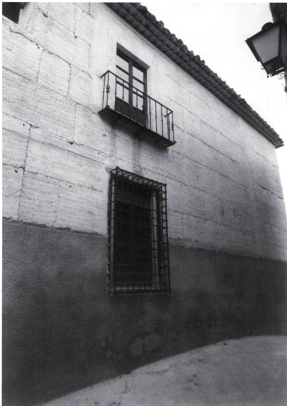
Fot. 7. Fachada al callejón del Portillo de la casa de los Galera. (Fot. S. Vico).
