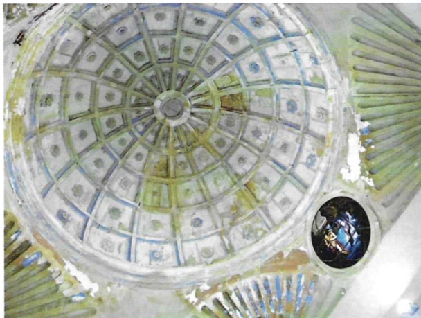
(5.9).- Iglesia de la Santísima Trinidad. Cúpula de la capilla de San Sebastián. Fot. J. S. Ferrer.
