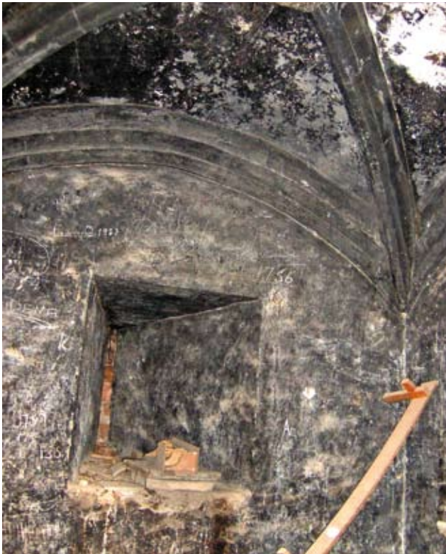
Fot. 18. Vista parcial de la librería.
