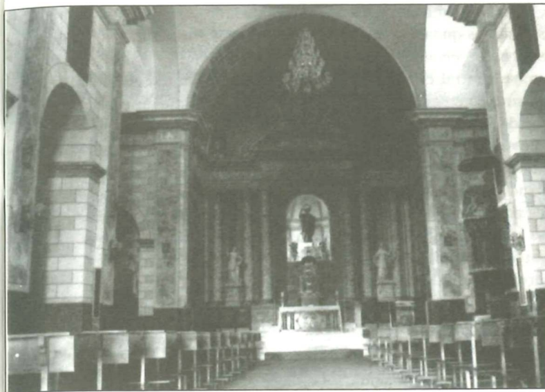
◆ Interior nave principal y presbiterio. Iglesia Parroquial.
