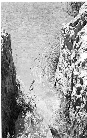
Fot. 11: Canal de entrada de agua de uno de los batanes de la laguna Batana con las hendiduras en la roca para la compuerta.
