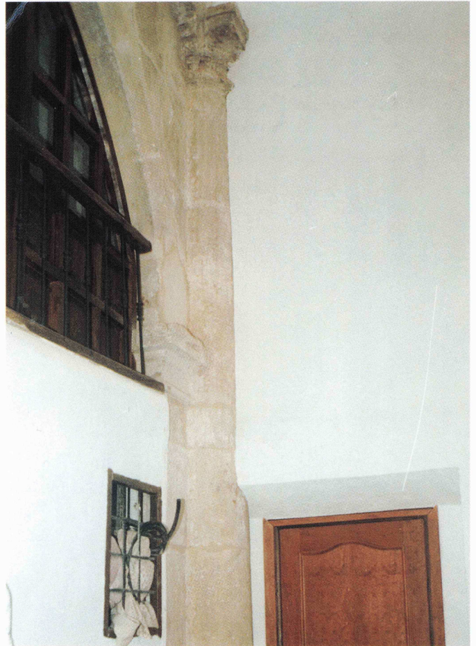
Fot. 16.- Lado del evangelio. Semicolumna del tercer-cuarto tramos y arcada de la tercera capilla. Se ve parte del tercer tramo, tramo que se convirtió en patio del café-bar del bajo y hueco de luces de las viviendas.
