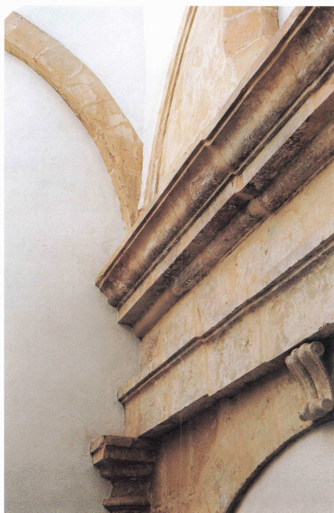
Fot. 19.- Lado de la epístola, tercer tramo. Parte alta del alzado y arranques de dos arcos de la bóveda.
