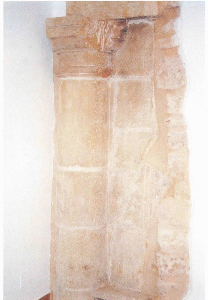
Fot. 8.- Lado de la epístola. Mitad superior de la semicolumna del primer-segundo tramos y parte del capitel y arranque del arco de paso a la primera capilla en su lado izquierdo.
