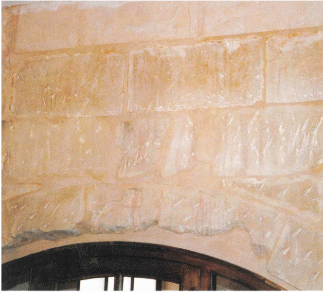
Fot. 24.- Alzado del primer tramo del lado del evangelio: estado actual del entablamento. Para permitir el enlucido con yeso de la piedra se destruyeron las molduras de la clave y del arquitrabe; a la altura que debía estar la cornisa se encontraron las cabezas de las vigas del coro, que se quitaron y en su lugar se colocaron los sillares nuevos que pueden contemplarse en la parte superior.
