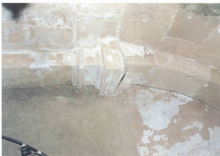
Fot. 12.- Lado de la epístola. Parte alta de la cuarta capilla. Está incorporada al Ayuntamiento; para ello se tapió el arco de comunicación con la nave y se abrió una puerta en el muro exterior de la iglesia.
