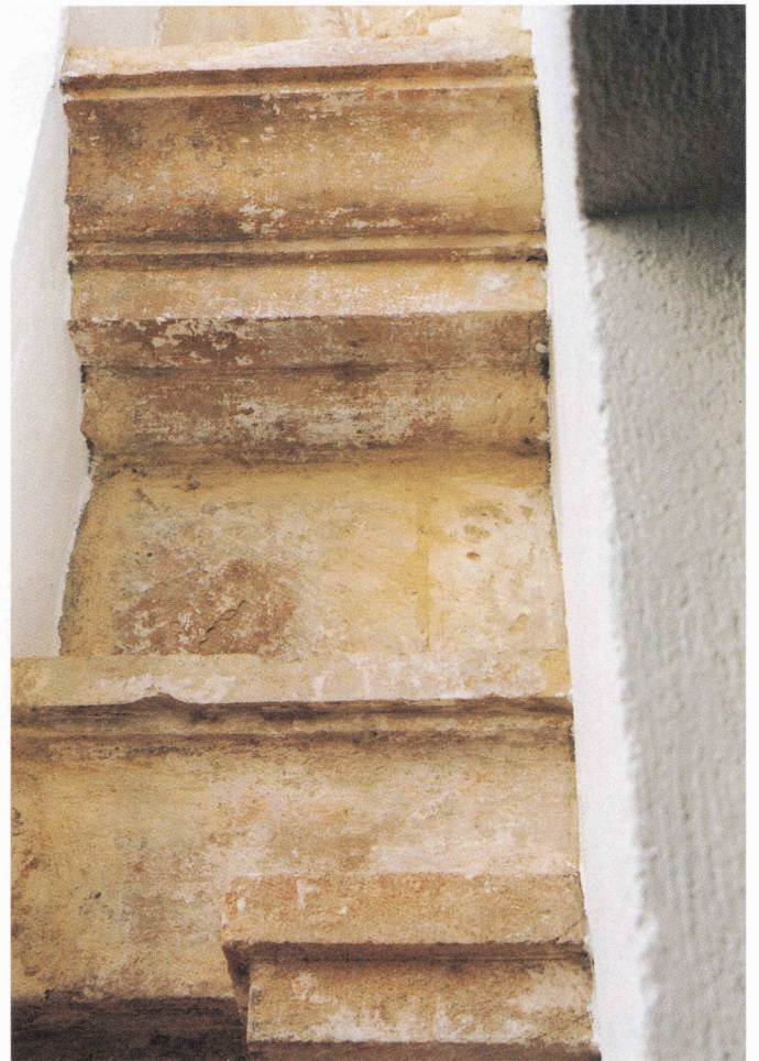
Fot. 23.- Alzado del tercer tramo del lado de la epístola, detalle. Parte superior del capitel de la semicolumna del segundo-tercer tramos, arquivitrabe, friso y cornisa.
