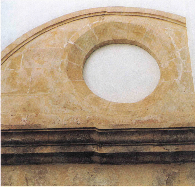
Fot. 20.- Lado de la epístola, tercer tramo. Cornisa, arco de la bóveda, óculo de iluminación y arranque del arco fajón del segundo-tercer tramos.
