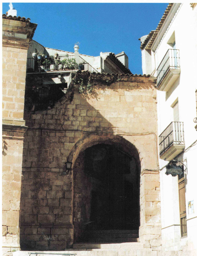
Fot. 2.- Arco de la Zapatería y mirador de las monjas (la terraza superior es una construcción reciente).
