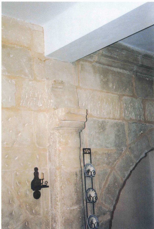
Fot. 9.- Lado del evangelio. Parte alta de la semicolumna del primer-segundo tramos, restos del architrabe y del friso, parte de la cornisa y del primer arco de la primera capilla y parte del de la segunda.
