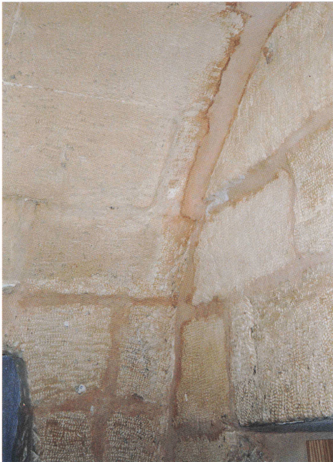
Fot. 15.- Bóveda y parte alta del muro frontal del presbiterio.
