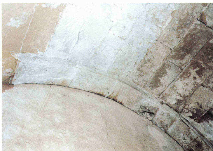
Fot. 13.- Bóveda de la capilla anterior.
