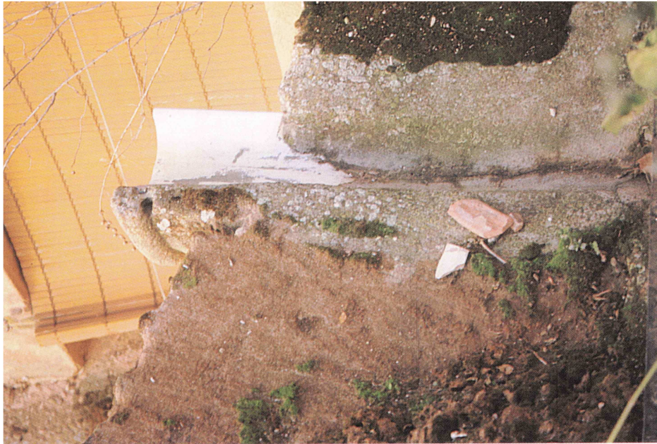
Fot. 28.- Canal y gárgola de la parte superior del muro del Arco de la Zapatería que tenían como finalidad posibilitar el desagüe de la terraza y, quizás, del corredor.
