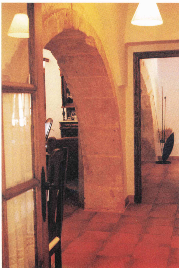
Fot. 11.- Lado del evangelio. Arcos de la primera y segunda capillas. Se destruyeron las bóvedas y partes altas de los contrafuertes para hacer el pasillo.
